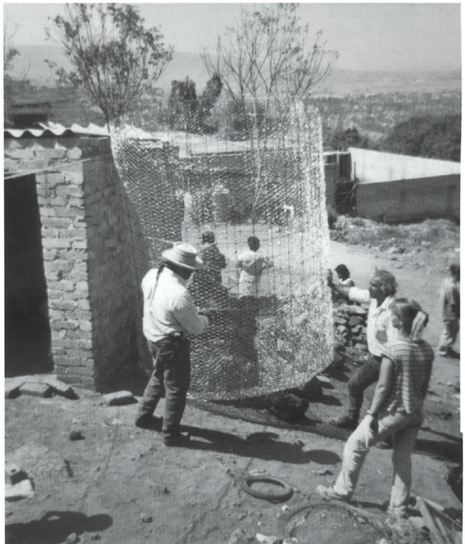
Construction du réservoir de captation d'eau
